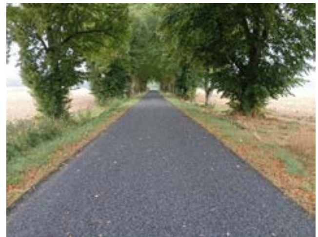
les Bienneries : reprofilage en grave et gravillonnage
