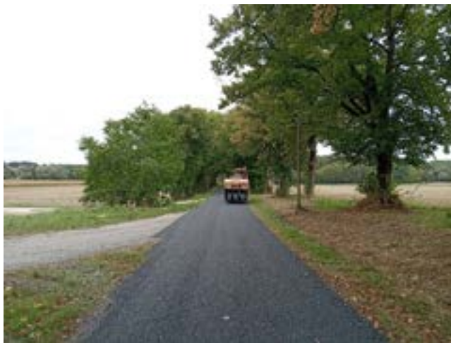
les Bienneries : reprofilage en grave et gravillonnage
