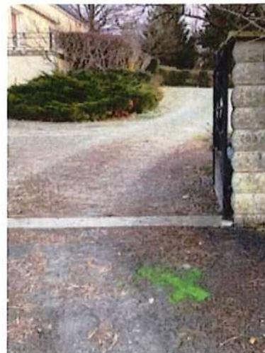
**Exemple :** Lors d'un raccordement, le technicien ne parvient pas à faire passer son câble fibre entre le point de branchement dans la rue et le garage de l'abonné où arrive son fourreau télécom. Le blocage est identifié plusieurs mètres après la barrière, là où il y a des plantations et des arbustes dans le jardin du client. Le blocage est sans doute provoqué par des racines qui obstruent complètement le passage.
